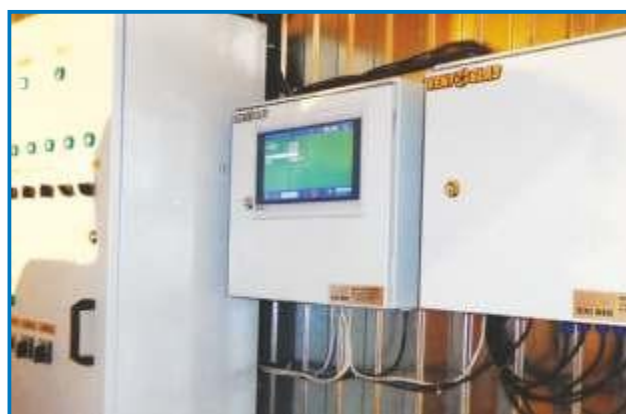
Блоки VENTOGLAS управляющие сушильной стеной прямого действия.
