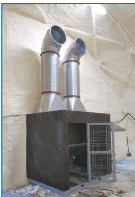
Типичный пример модуля общеобменной (пространственной) вентиляции – «Дракон». Управляющие блоки VENTOGLAS вынесены за пределы камеры хранения (хранение продукции в контейнерах)
